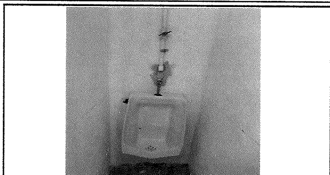
Foto 8: Sustrucción de mingitorio
