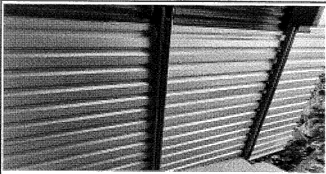
Foto 3: Sustitución de estructura de soporte
